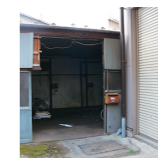
BEFORE 工場・倉庫
